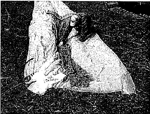
3) Lay jute matting
